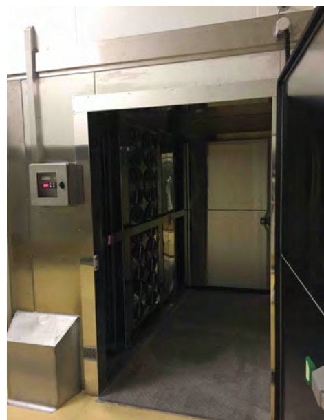
Porte sur mesure 2100 x 1200 - Sol en tôle larmée pour roulage intensif des chariots industriels et transpalettes.
