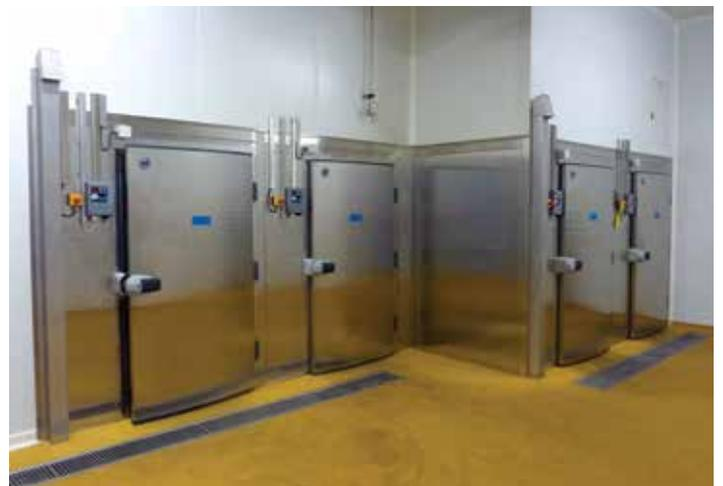
Les 4 cellules ACFRI (2 modèles CSP 6 et 2 CSP 10) implantées sur le nouveau site, permettent le refroidissement quotidien de 12 t de cakes par jour
