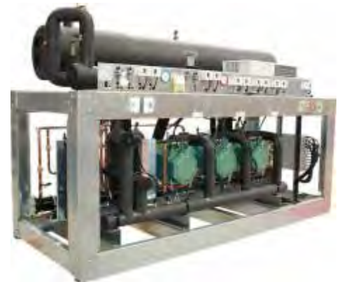
Centrale au CO 2
